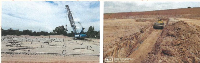
งานปรับพื้นที่สำหรับก่อสร้างทางวิ่งและทางขับที่ 2 ระยะที่ 1 และลานจอดของศูนย์ซ่อมบำรุงอากาศยาน มีความก้าวหน้าร้อยละ 62.51
