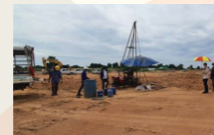
โกลเบลแอร์แอสโซซิเอตส์ (ผู้ประกอบการให้บริการน้ำมันเชื้อเพลิงอากาศยาน) ปัจจุบันอยู่ระหว่างการเตรียมพื้นที่การก่อสร้าง มีความก้าวหน้าร้อยละ 4.29
