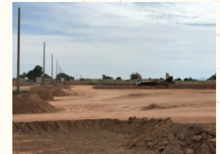
บักริม (ผู้ประกอบการไฟฟ้าและน้ำเย็น) ก่อสร้างส่วนงานปรับระดับดิน มีความก้าวหน้าร้อยละ 86.89
