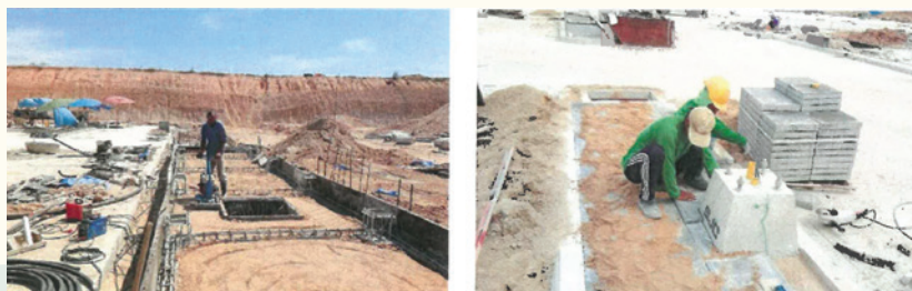
งานก่อสร้างปรับถมดินและอื่น ๆ บริเวณพื้นที่พัฒนาอุตสาหกรรมการบิน ดำเนินการเสร็จสมบูรณ์
