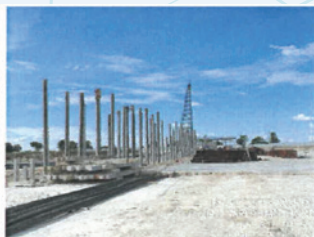
งานก่อสร้างโรงหล่อชิ้นส่วนที่พานทอง
