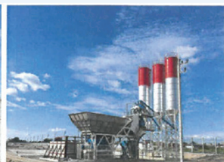
งานติดตั้งโรงผลิตคอนกรีตผสมเสร็จ พานทอง
