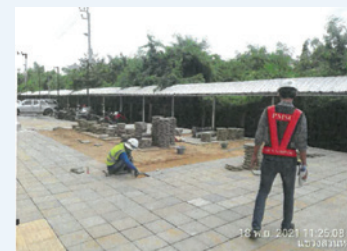
งานปูทางเท้า งานแถมปีกคอนกรีต จุดรอรถ
