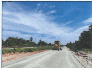
งานปูวัสดุพื้นทางหินคลุก
